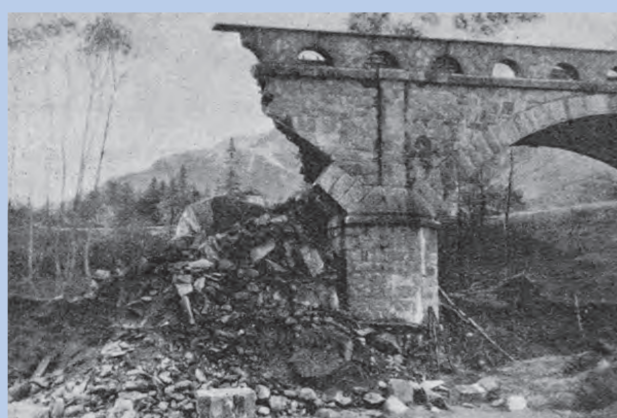
Bridge culture in Val Bregaglia: renovation of the bridge over the Maira at Castelmur after the 1927 flood with a new concrete and stone arch, doubling the central span Culture du pont dans la Bregaglia : reconstruction du pont sur la Maira à Castelmur après la crue de 1927 avec une nouvelle arche en béton et en pierre, doublant la portée centrale
