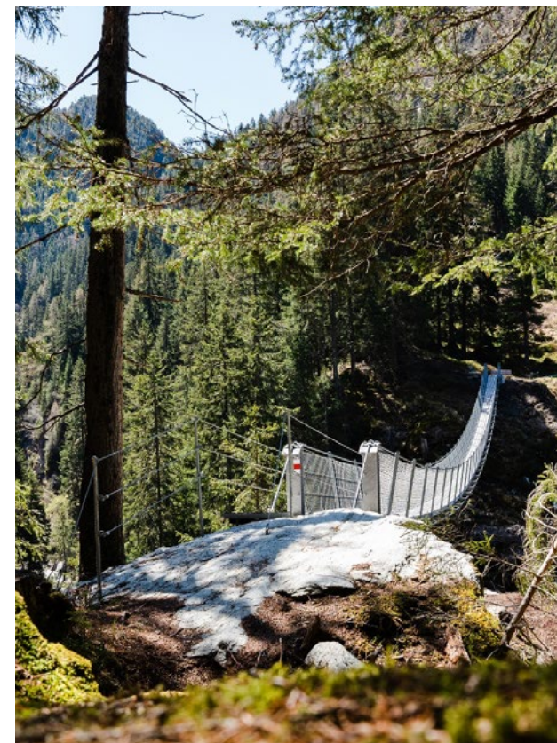
Beispiel einer Seilbrücke (Innerferrera, Foto: Viamala Tourismus)
